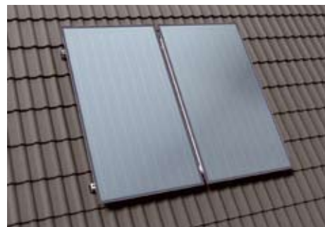
Монтаж «Поверх кровли»
